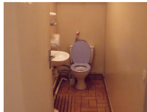
03 : Sanitaire commun RDC
