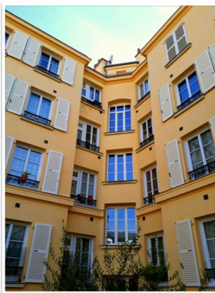
Immeuble Clichy, façade intérieure (Clichy)
