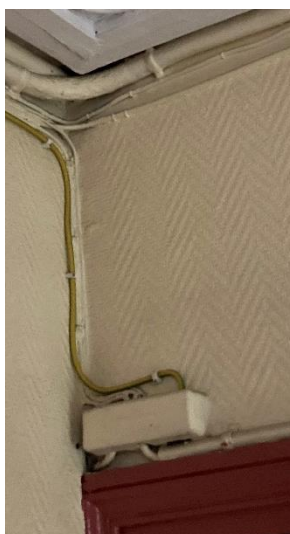
Bornier de terre à différents étages
