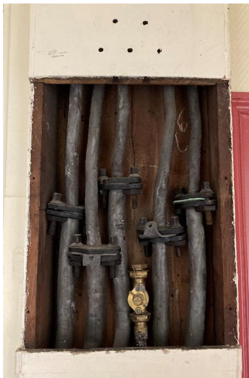
Colonne gaz – étage courant
