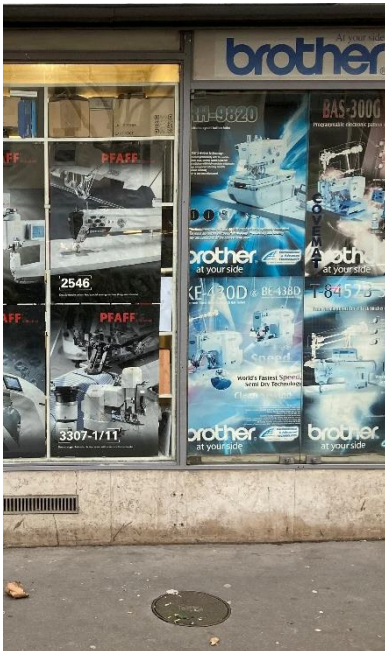
Regard avec arrivée gaz sur rue
