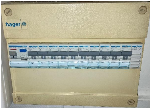
Logement A 0321 avec son complément pour le chauffage électrique
