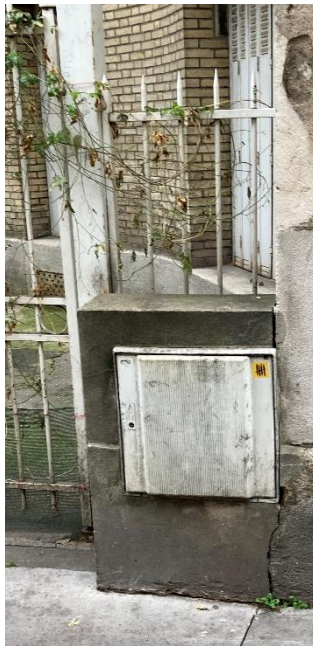
Regard avec arrivée gaz sur rue pour le 3, passage de Melun
