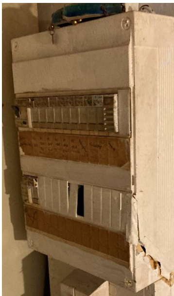
Logement A 0002 – porte 72 à RdC
