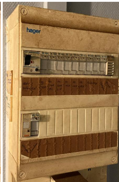
Logement B 0013 à RdC
