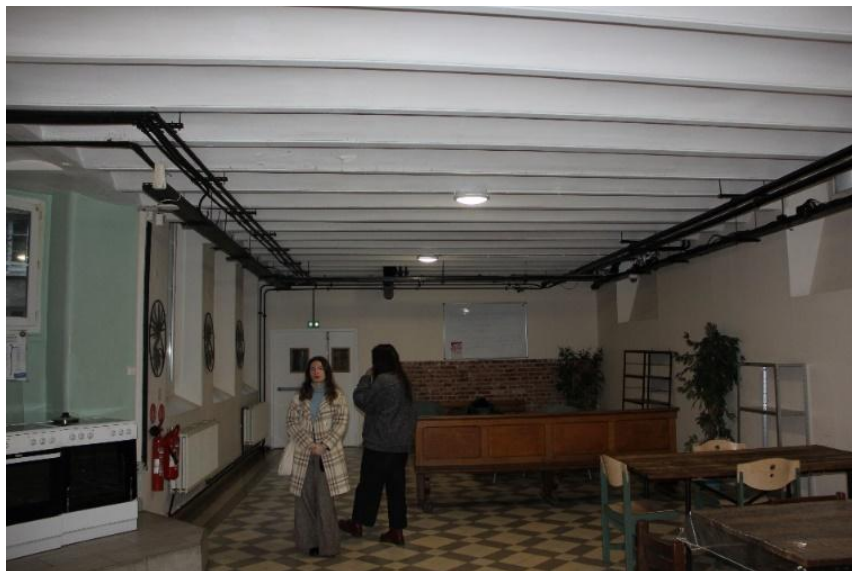
Le plafond de la salle, rythmé par les poutrelles.
