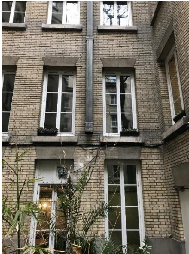
Façades sur cour : un traitement tout aussi qualitatif que côté rue, des menuiseries qui respectent le dessin d'origine.
