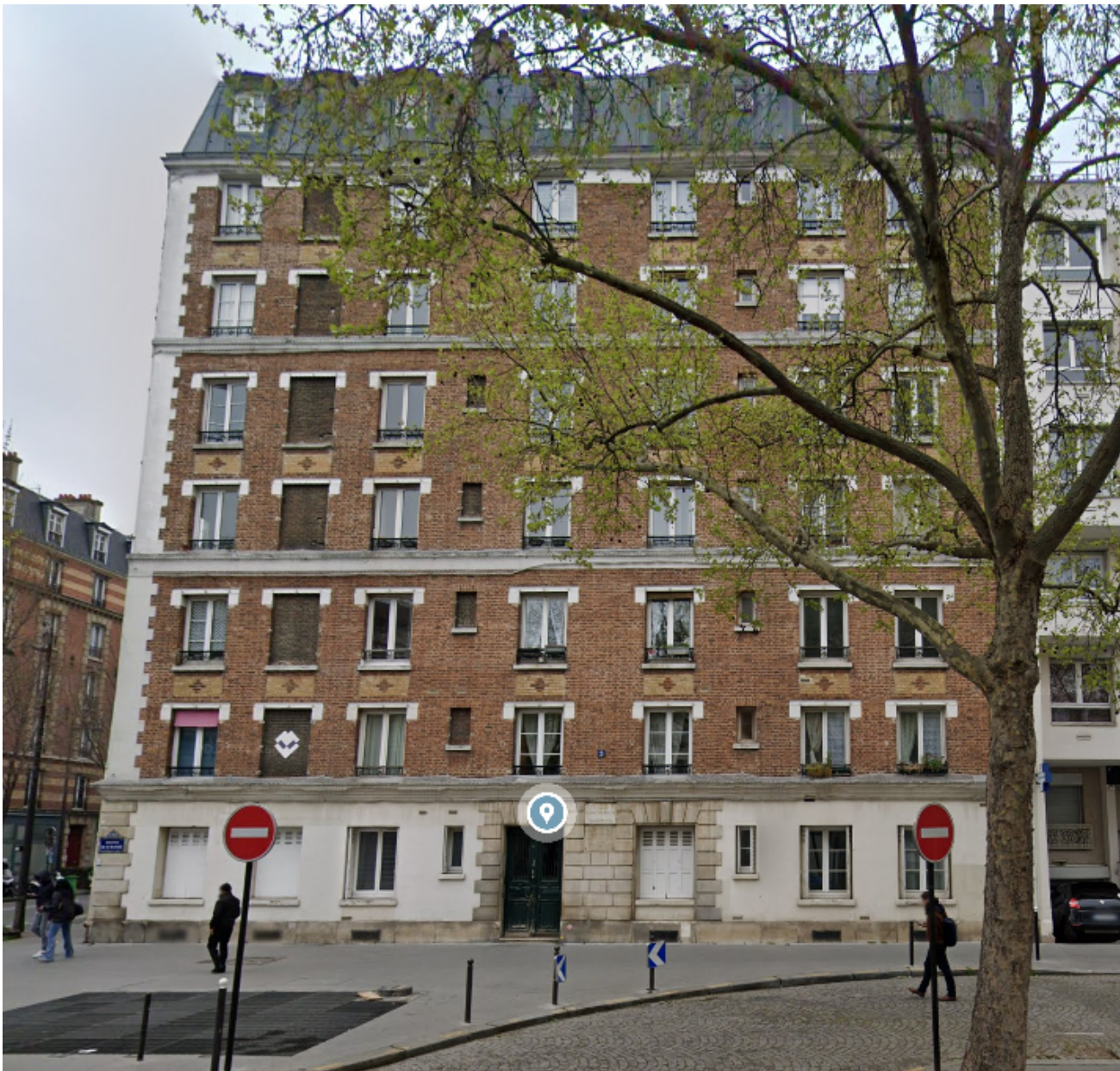
Photographie du bâtiment dans son environnement proche depuis l'avenue de Saint-Mandé
